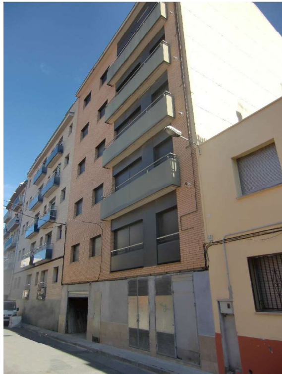
FAÇANA CARRER DE SANTA MAGDALENA 46
